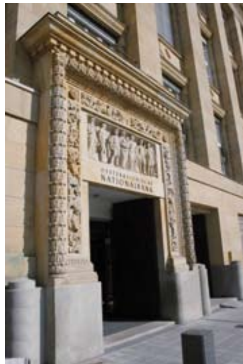
Hauptgebäude (OeNB I)
