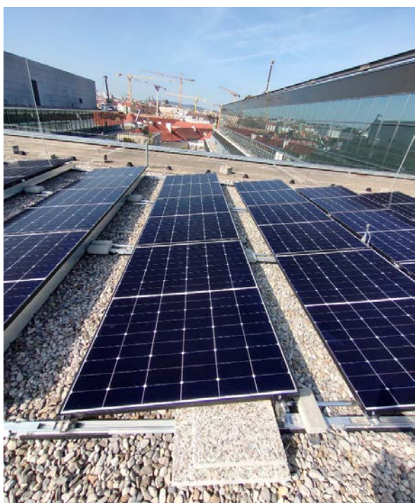
Neue Photovoltaik-Anlage am Dach des Geldzentrums in Wien
