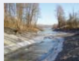
Vor und nach den Renaturierungsarbeiten am Inn
